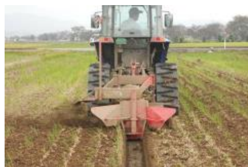
オーガ式溝掘機などで しっかりと掘る
