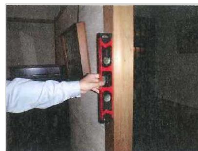
水平器による柱の傾きの計測
