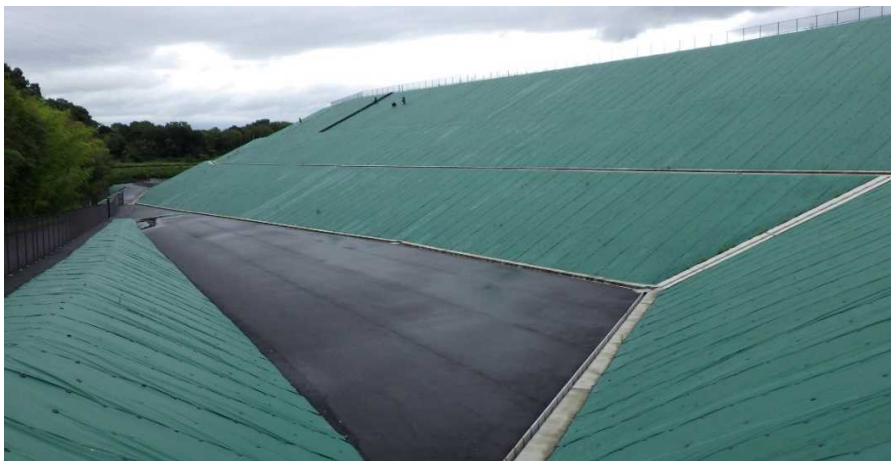
写真① 西市道側の様子
