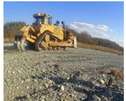
細粒分の流下促進によるアユの産卵環境の改善のための愛知川固定化砂州におけるアーマールコート破壊（河床耕耘）事業
