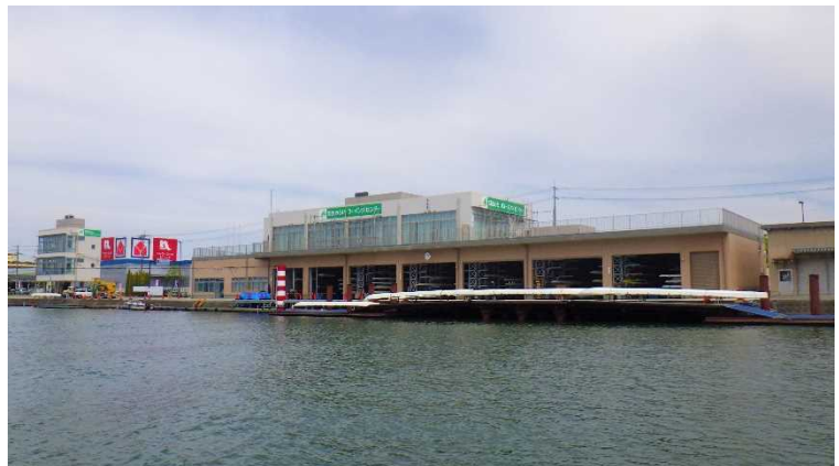
管理棟・艇庫を琵琶湖から撮影
