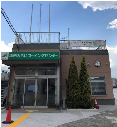
管理棟・艇庫入り口を撮影
