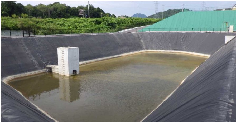
写真① 調整池の様子
