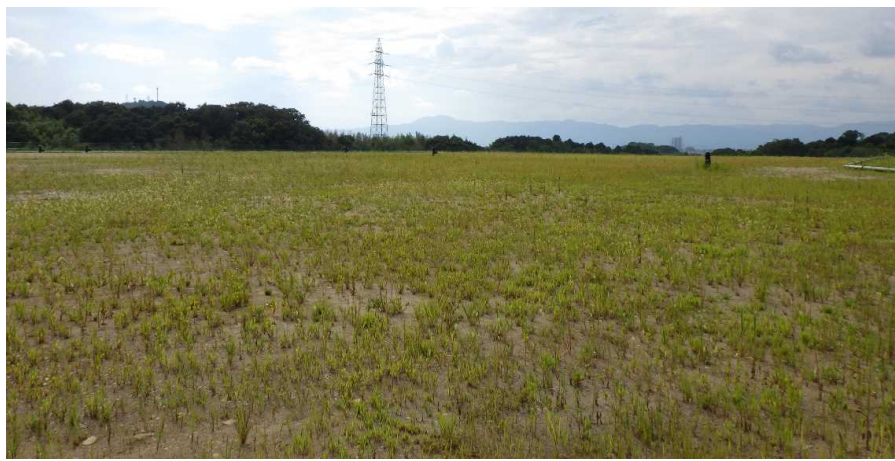
写真② 天端部の様子
