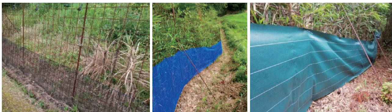
防風ネット（左：黒4mm目 中央：青4mm目）、防草シート（右）の組み合わせ
