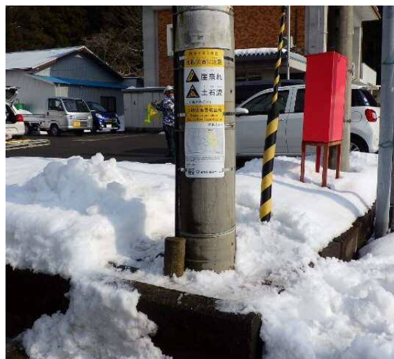
地点④の設置状況
