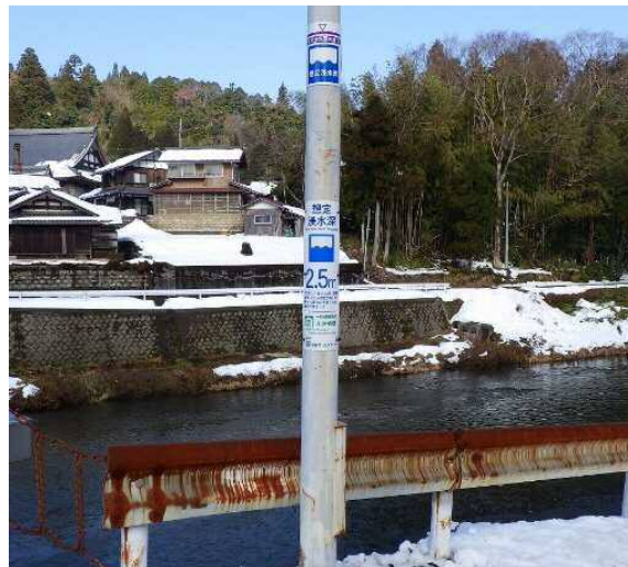
地点③の設置状況
