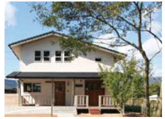
▲びわ湖材を使用した住宅
