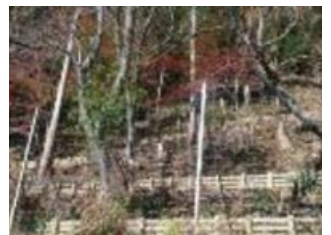
▲土壌流出防止施設事例
