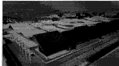
湖陸風を取り入れる屋根形状 7月20日 12時の太陽高度
