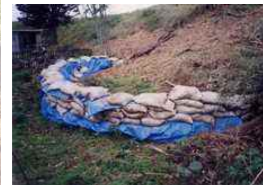
平成10年台風6、7号姉川堤防漏水
