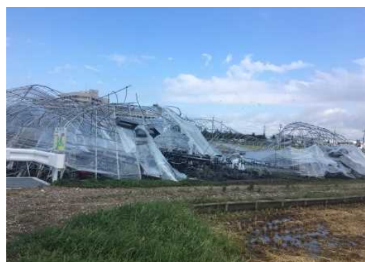
図 4 - 4 平成 30 年度台風 21 号による農業用ビニールハウスの倒壊
