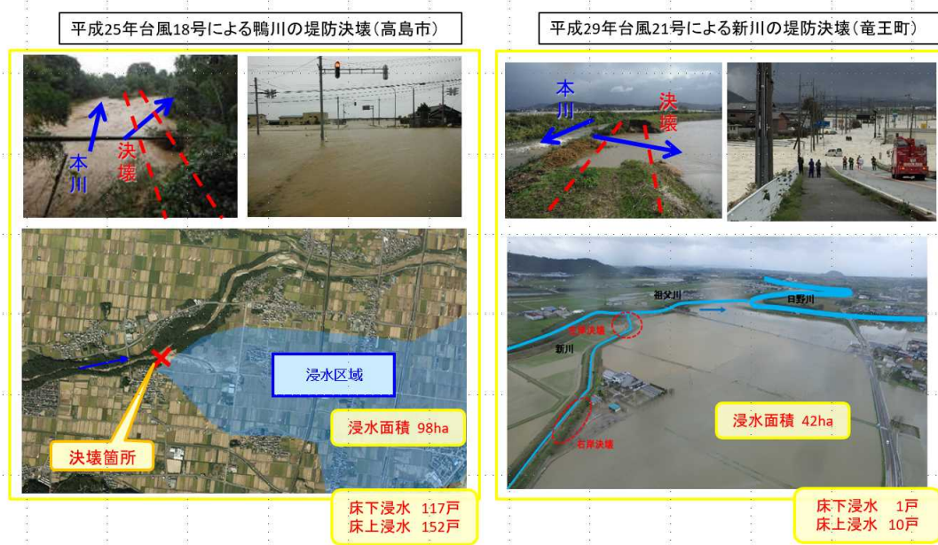
図 4 - 14 近年、県内で生じた水害の状況
