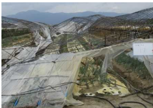
図 4 - 4 平成 30 年度台風 21 号による農業用ビニールハウスの倒壊
