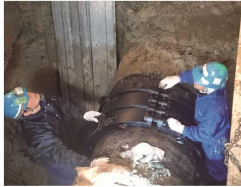
三つ割による復旧状況
