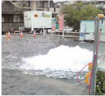
八幡安土バイパス漏水
