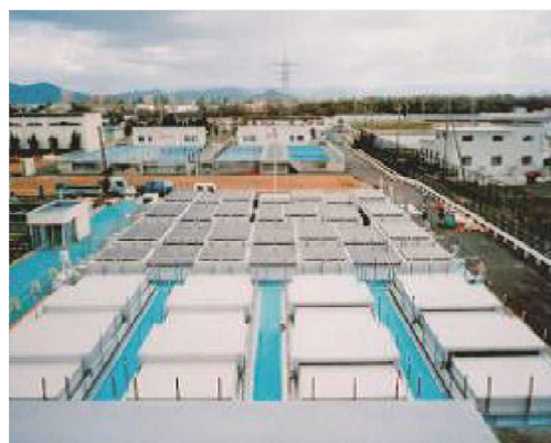
吉川浄水場沈殿池覆蓋化
