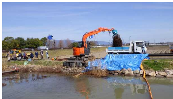
引き寄せたオオバナをダンプトラックへ積み込み
