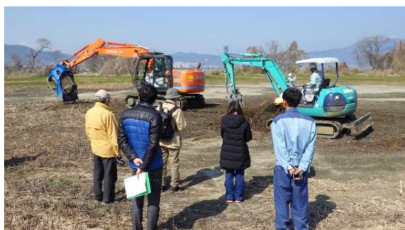
バックホウによる掻き取り作業
