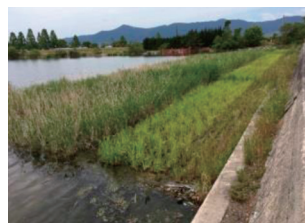
底質改善対策 （覆土工・植生工）
