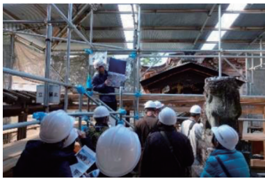
県指定有形文化財 沙沙真神社透塀 保存修理工事現場公開
