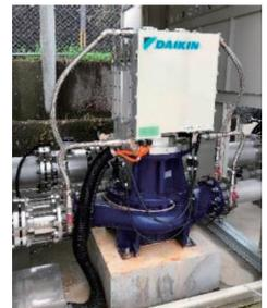
管水路用マイクロ水力発電システム（近江八幡市長福寺町）
