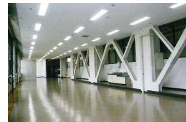
建築物の耐震改修
