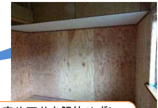
床や天井を解体せずに設置した2階補強壁(上下空き)
