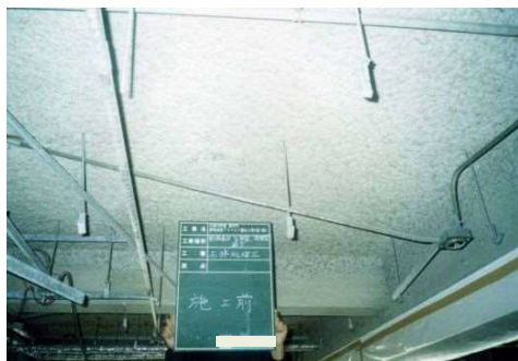
アスベスト除去前
