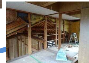
採光等を確保しつつ地震に耐える壁設置(窓空き)
