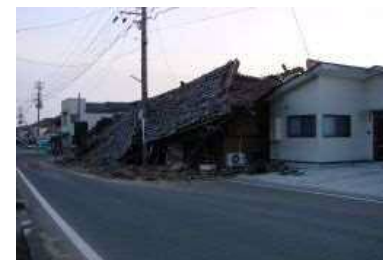
地震で倒壊した建築物
