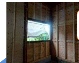
採光等を確保しつつ地震に耐える壁設置(窓空き)
