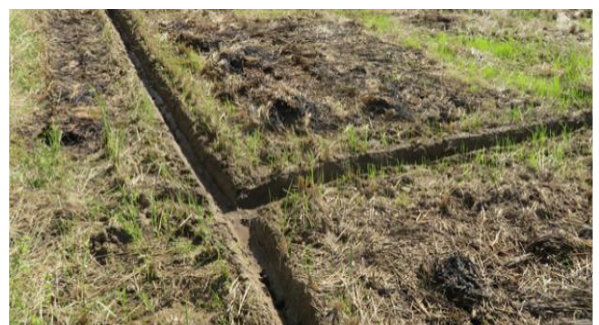
溝のつなぎ目の部分は必ず連結する
