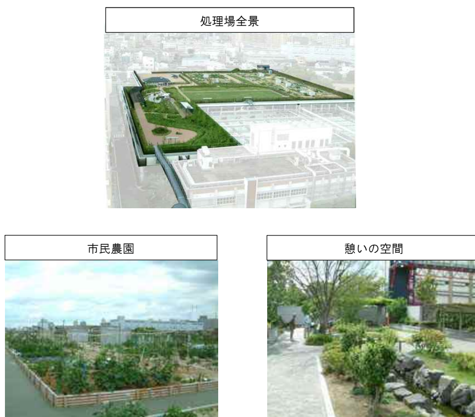
図 5-12 大阪市放出下水処理場写真
