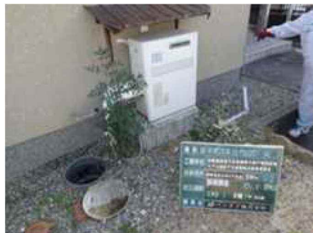
図 5-36 誤接続調査状況
