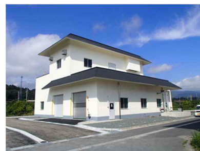
図 5-46-2 高島市共同汚泥処理施設
