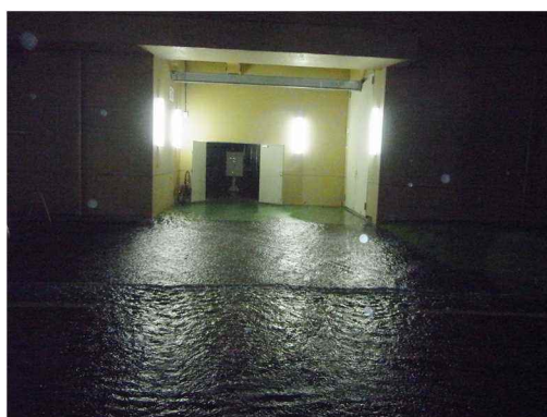
図 5-31 平成 25 年台風 18 号 下水処理場浸水状況
