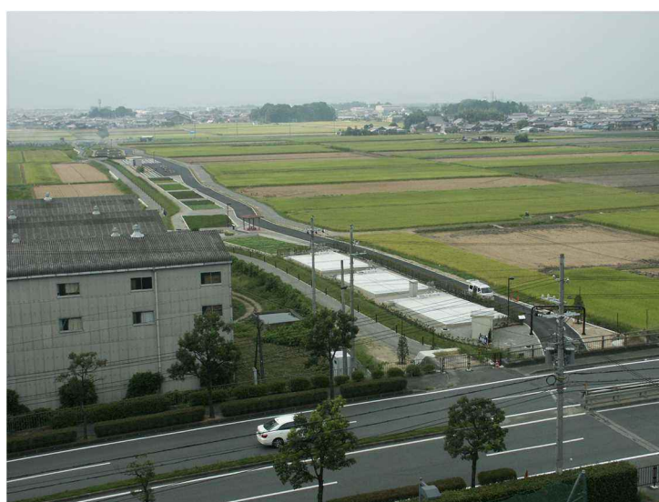
図 1-7 山寺川市街地排水浄化対策施設の全景
