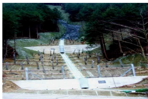
山腹土留工を設置
