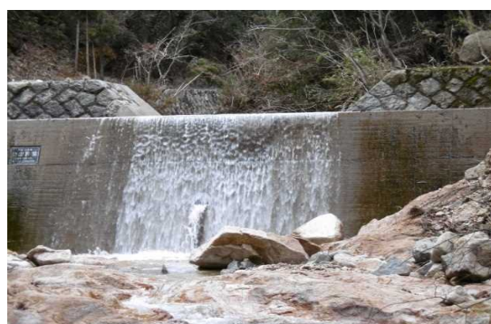
コンクリートによる補強で機能回復
