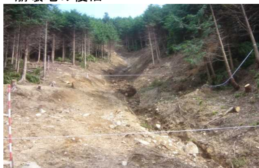
甲賀市土山町大河原(施工前)
