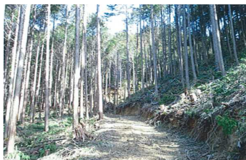
作業道施工後(間伐も実施)
