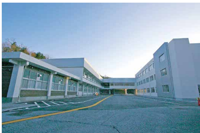
玄関前（左手が3階を減築した校舎、右手が普通教室増築棟）
