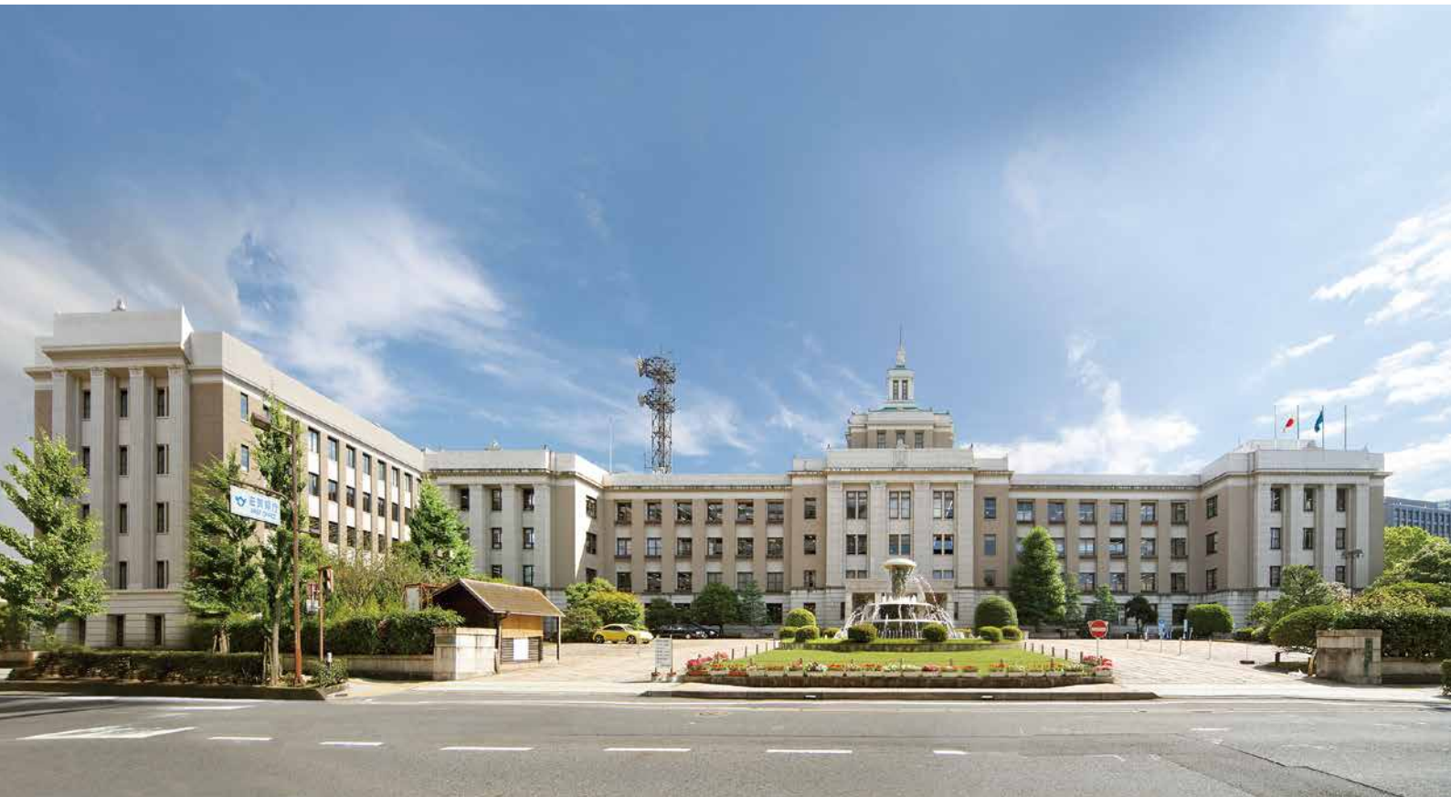
滋賀県庁舎全景 左側道路沿いに危機管理センターが位置する
