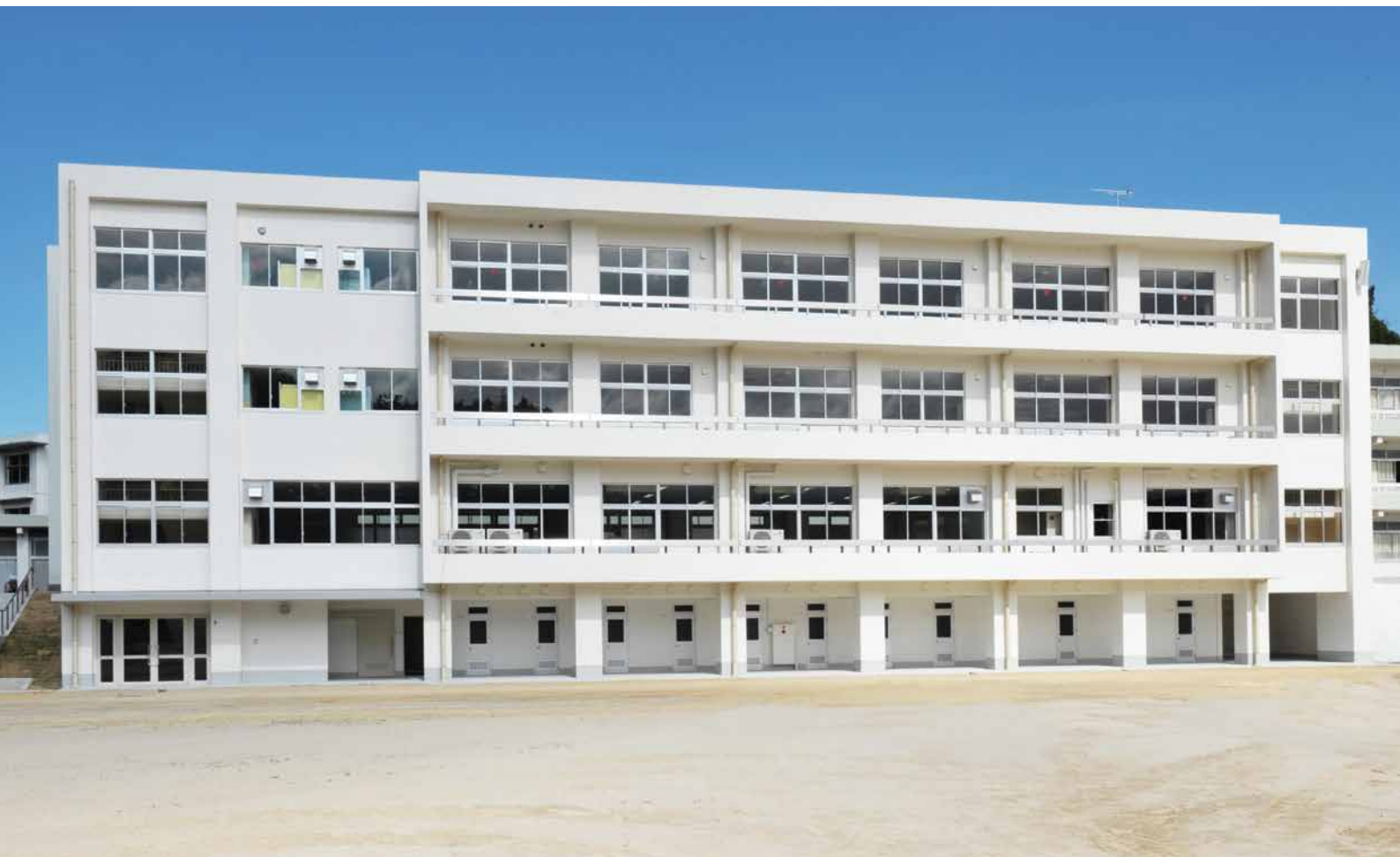
普通教室増築棟（最下階は地下階）
