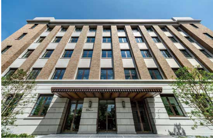
西側ファサード見上げ
