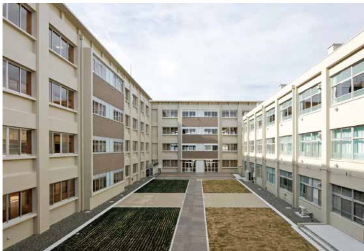
中庭まわり（左側と正面側：改築部分 右側：耐震改修部分）
