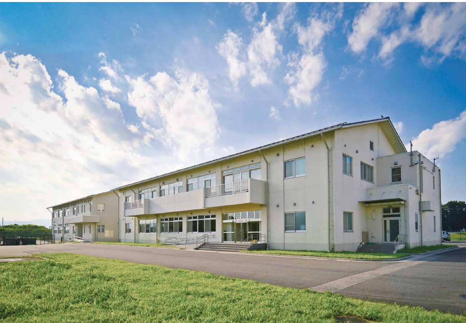
管理本館棟（右側）と水質試験棟（左側）
