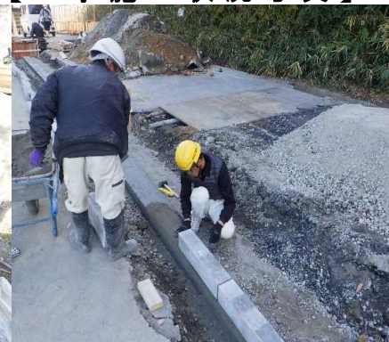
① 工事用進入路
