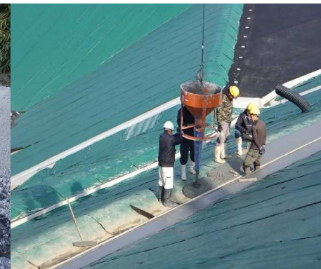
④ 雨水排水工
