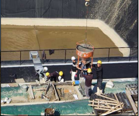
④ 雨水排水工 擬木階段のコンクリート打設を行っています。
