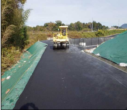
③ キャッピング工 C工区のアスファルト舗装を行っています。
