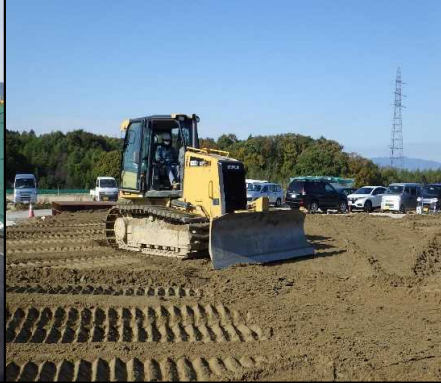
③ キャッピング工 水平部の盛土を行っています。
