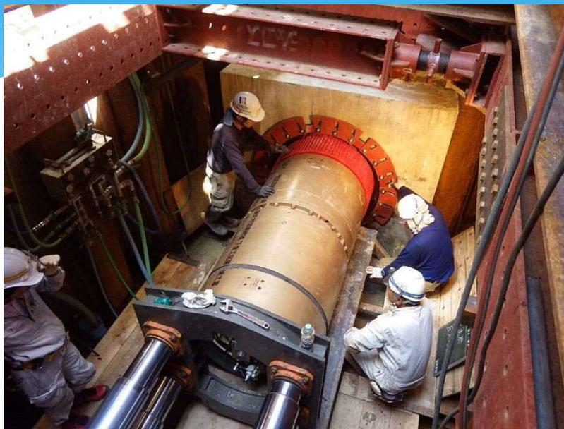
湖東幹線下里工区 (掘進機設置状況)
