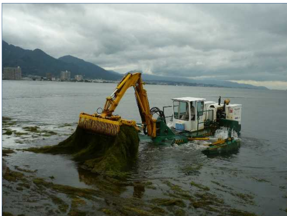
[大量繁茂した水草の除去作業]
