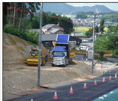
① 工事用道路工 仮設進入路を復旧盛土しています。
