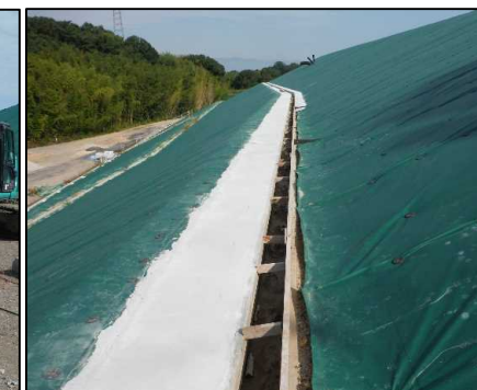
③ キャッピング工 小段排水張りコンクリート型枠設置状況です。
