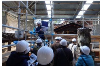
県指定有形文化財 沙沙貴神社透塼 保存修理工事現場公開
