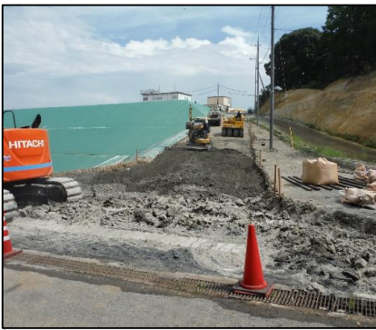
① 工事用道路工
