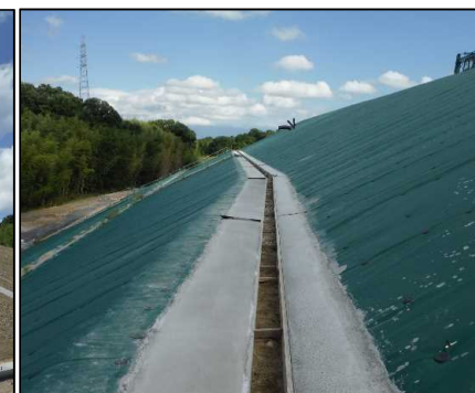
④ 雨水排水工
