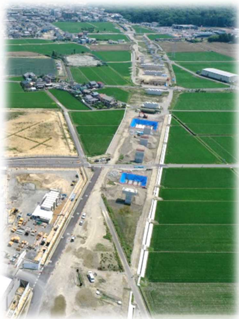
国道 8 号野洲栗東バイパス (工事中)
