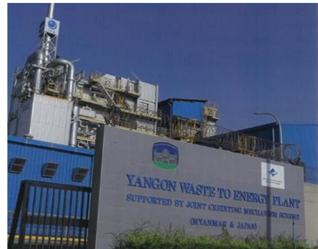
国際展開によりヤンゴンで稼働中の廃棄物処理施設 出典：環境省
