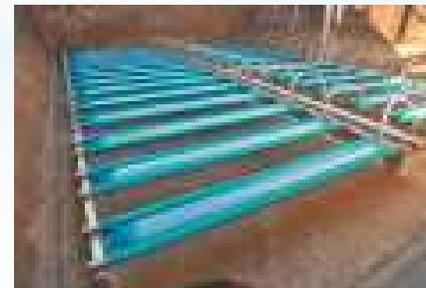
湖西浄化センター3、4号池の改築更新工事において微生物による分解促進のため水槽に空気を送る装置。微細な気泡を噴射する。微細な気泡とすることで送風量を減らし消費エネルギーを削減できる。
