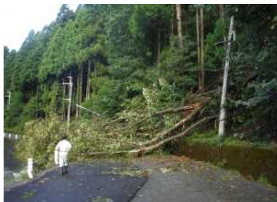
平成30年9月の台風21号で倒木が発生し、高島市朽木で道路途絶が発生
