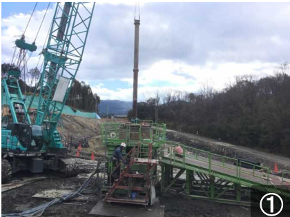
撮影日 平成31年(2019年)2月1日 ・生コン打設のためのトレミー管設置
