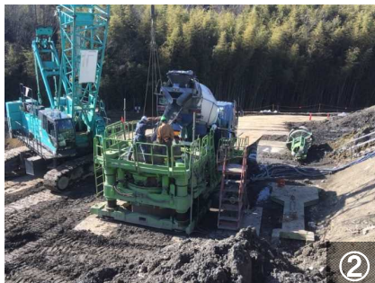
撮影日 平成31年(2019年)1月30日 ・生コン車によるコンクリート打設
