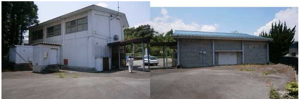
東から西を望む（裏面全景）
