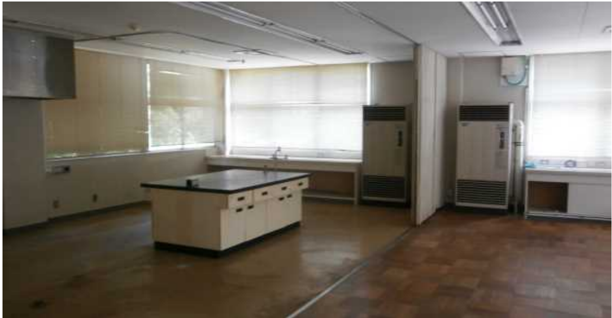
本館棟 1F実験室
