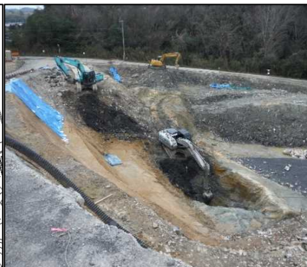
①-1 D・E工区 E工区の掘削を行っています。
