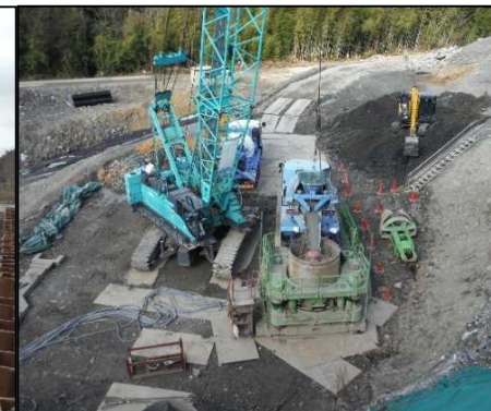
⑤ 底面・側面遮水工 生コンクリートを打設しています。
