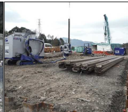
② 有害物掘削工 F区画の鋼矢板引抜を行っています。
