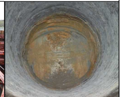
⑤ 底面・側面遮水工 全旋回オールケーシング工法掘削完了の地山状況です。
