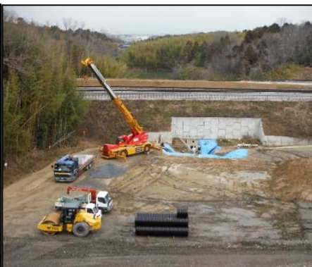
⑥ 洪水調整設備工 集水柵を設置しています。
