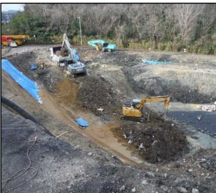
①-1 D・E工区 E工区の掘削を行っています。
