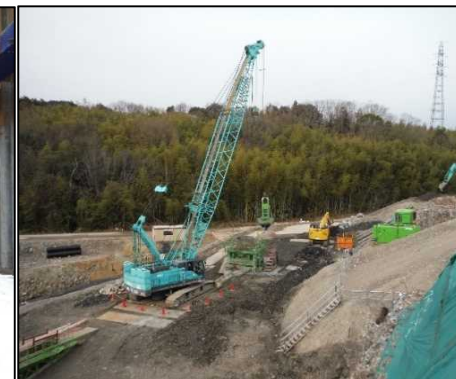
⑤ 底面・側面遮水工 全回転オルケーシング工法にて底面遮水を行っています。
