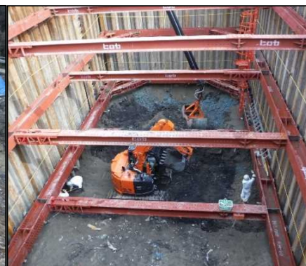
② 有害物掘削工 F区画の有害物掘削を行っています。
