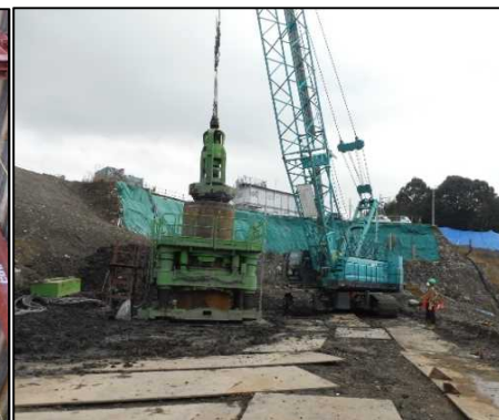
⑤ 底面・側面遮水工 全旋回オールケーシング工法にて底面遮水を行っています。
