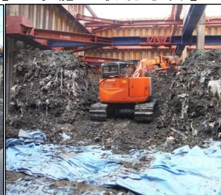
② 有害物掘削工 C区画の有害物を掘削しています。
