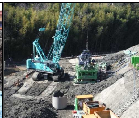
⑤ 底面・側面遮水工 生コンクリートを打設しています。
