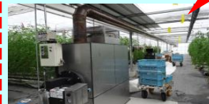
BDFボイラー
