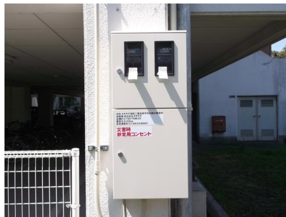
災害時非常用コンセント
