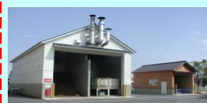
木質バイオマスボイラー
