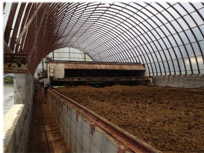
発酵堆肥化施設
