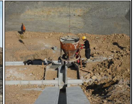
⑤ 雨水排水工
