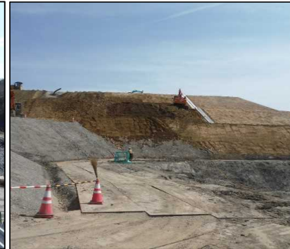
④ キャッピング工
