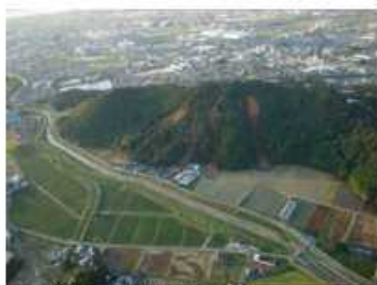
安養寺山土砂災害（栗東市）
