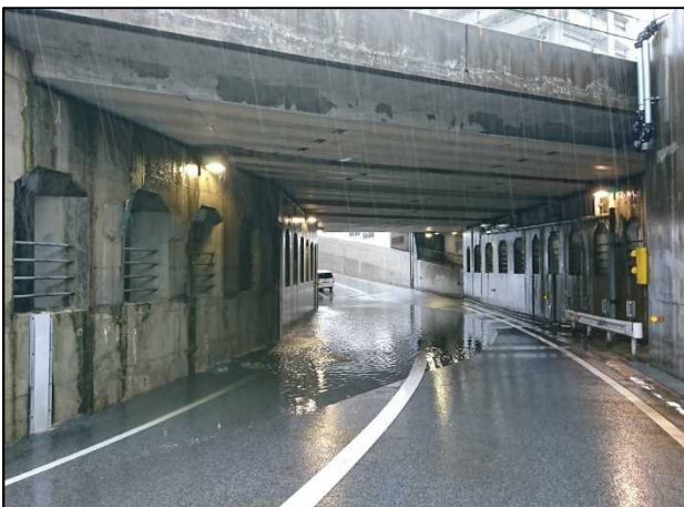
図-2 事故発生時の冠水状況
