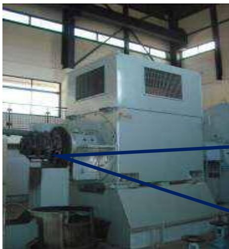
揚水機(高圧電動機)の焼損による緊急停止事故
