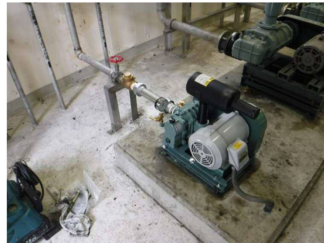
集落排水処理施設の機能強化工事の状況 20
