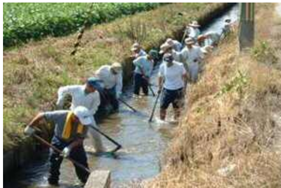
排水路の泥上げ
