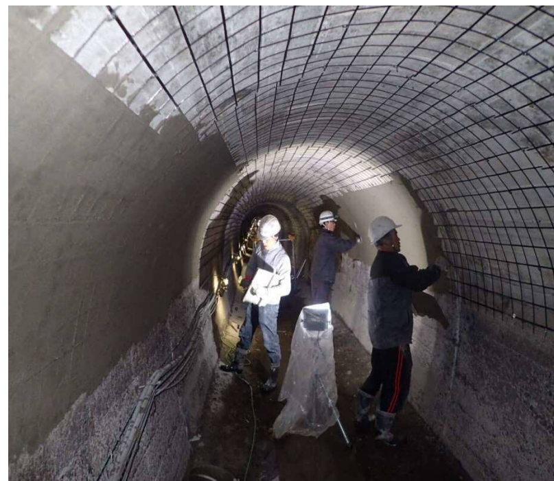
水路トンネルの改修 (FRPグリッド(強化プラスチック製補強材)の設置)
