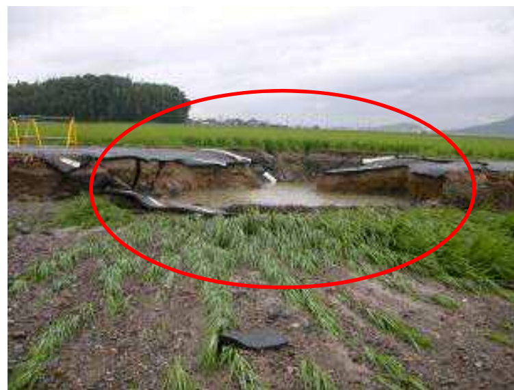
圧送管破損漏水事故による被害状況
