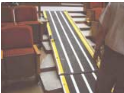
(スロープの設置)
