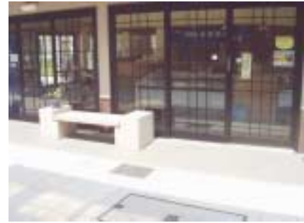
(歩道から店内への段差をなくし、休憩用のベンチも設置)
