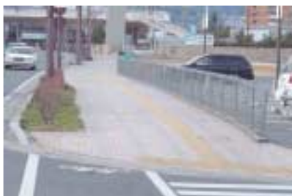
(車道との段差に配慮した歩道)
