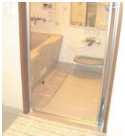
(段差がなく、手すりの付いた浴室)
