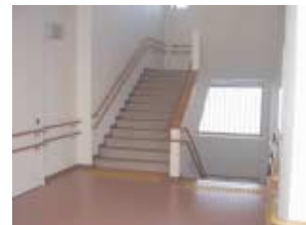
(背の高さに対応できる二段の手すりがある階段)
