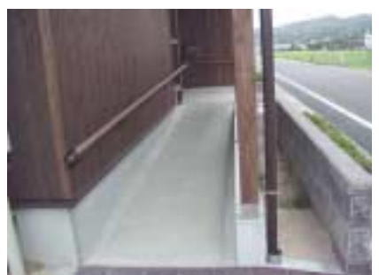
(玄関までスロープにし、手すりを設置(高島市))
